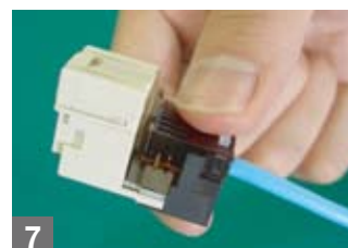
7 ロックがかかる場所まで押し込みます(プライヤを用いる場合はコネクタを破損しないようご注意ください)
