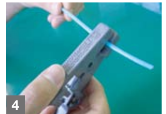
4 ストリッパを用いて30mm程度外被をむきます
