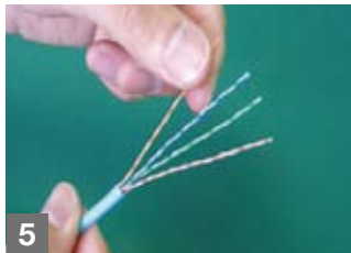
5 対より線を横一列に並べ、よりを戻します(外被内に入っている対より線(約10mm)が重なっていると混線の原因となりますのでご注意ください)
