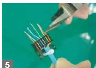
5 余った心線およびケーブルバンドをカットします
