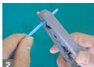
2 ストリッパを用いて30mm程度外被をむきます
